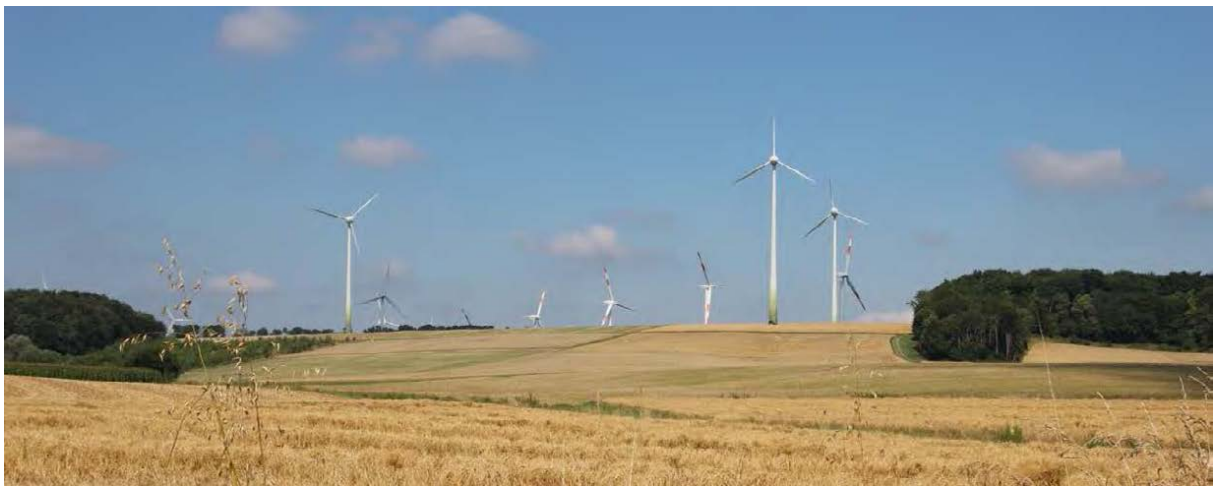
Abb. 62: Bildausschnitt von Sichtkegel G (Windpark bei Wertheim)
